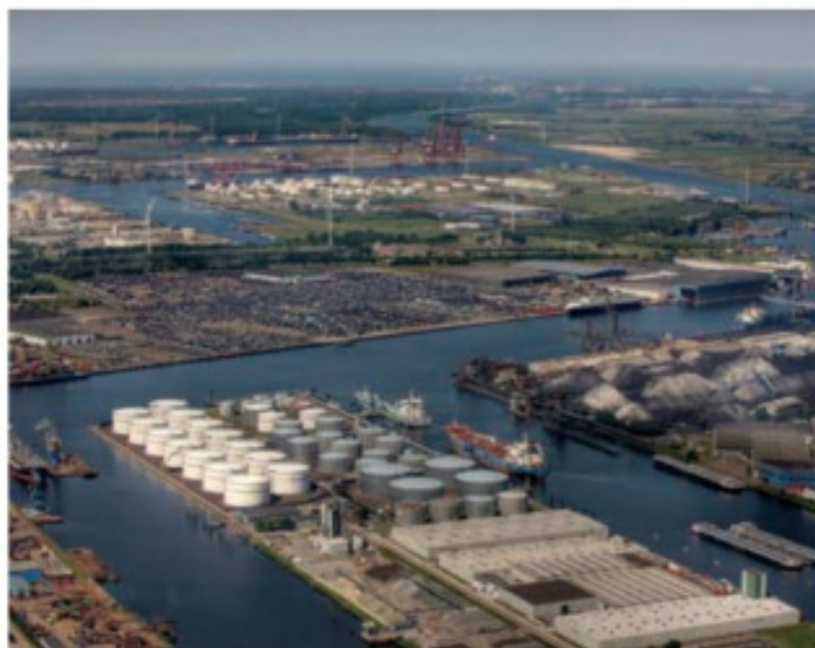
De opslagterminals in Amsterdam-Westpoort zijn via AMAS actief betrokken bij het Platform Industriële Incidentenbestrijding. FOTO: PETER ELLENBAAS
